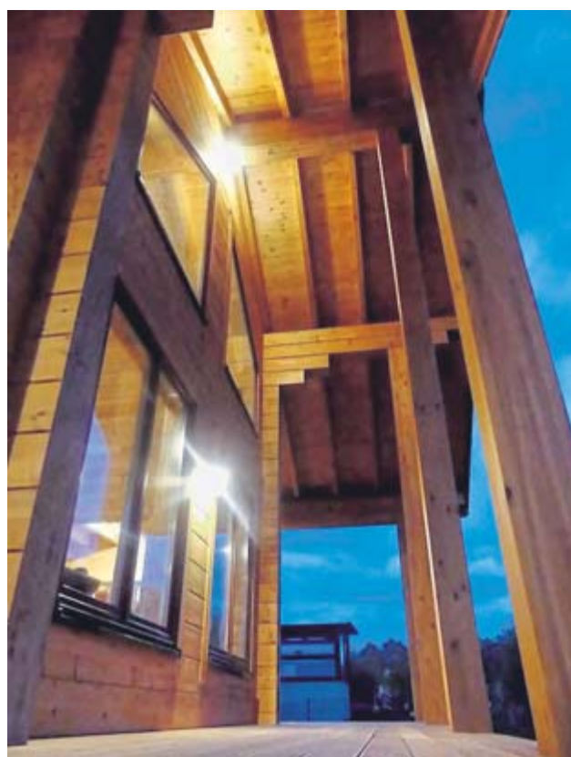
Ein Blick unter den Holzvorsprung der Terrasse.
